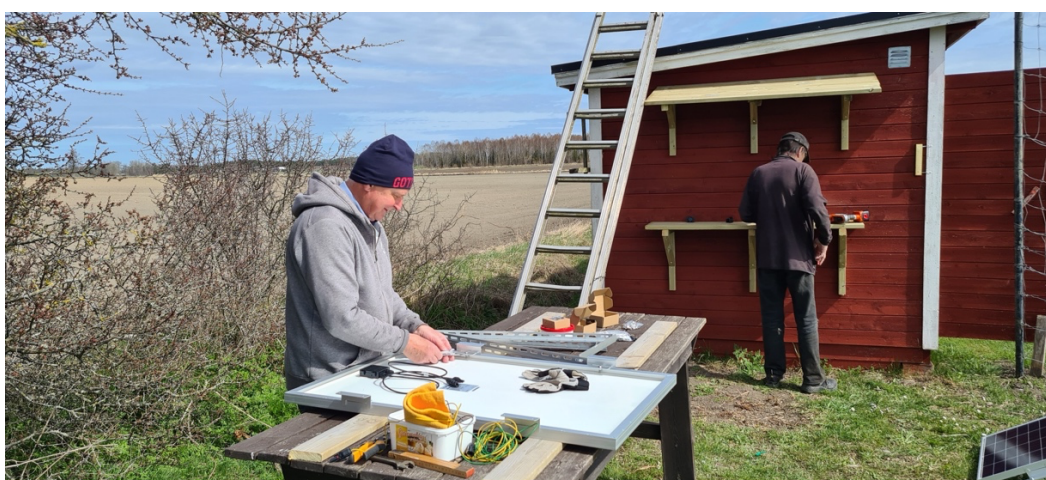
Solpanelerna monterades permanent på stativen och en hylla för laddning med skärmtak byggdes. De fyra uttagen för laddning fästes in i väggen.
