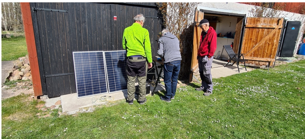
Provkörning av solpanelerna i solskenet vid laduväggen
