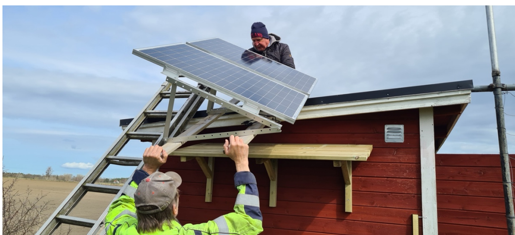
Panelerna lyftes upp på taket med anfallsvinkeln mot solen i direkt söderläge (azimut 0) och lutningen ca 25 grader. Inställningen ger god verkningsgrad, ca 95 % av W_p
