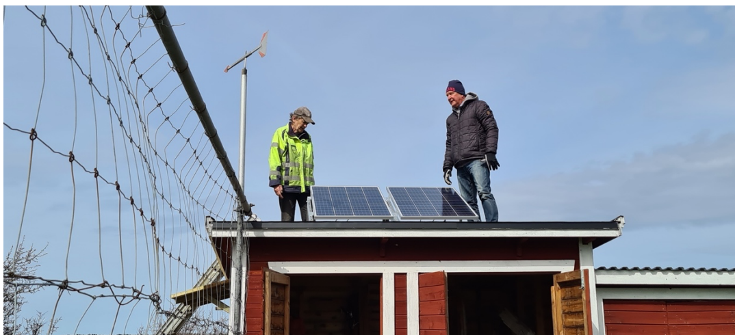
Solpanelerna monterade i rätt läge och stativen fast förankrade i taket.
